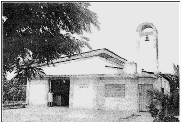
Antigua Capilla de San Benito con su campanario, que fue convertida en panadería
